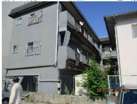
「Tマンション」 築年不明、15戸+店舗2 RC造3階建て、
