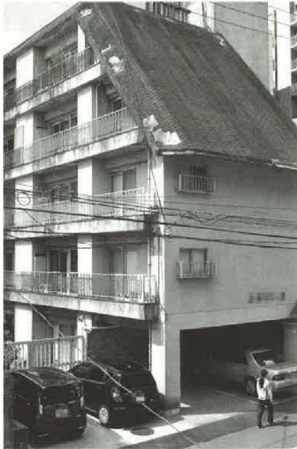
錦町のマンションは屋根が一部欠落している。(一部画像を修正しています)
