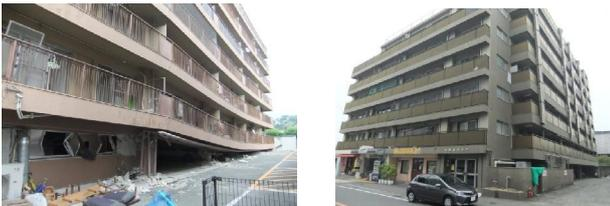
次に中央区のマンション3棟の被災状況を調査しました。せん断亀裂や壁の崩壊、EXPJ部分の破損がみられました。
