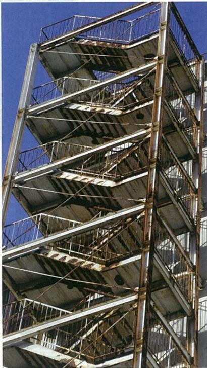
老朽化し、鉄さびで覆われた階段部分
