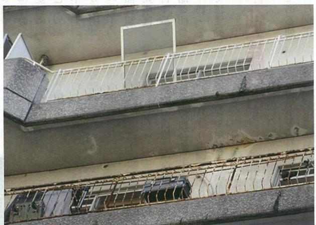
さびだけでなく、外壁の一部が剥離した痕跡も見える
